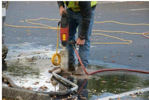
Abbildung 6: Bohren des Lochs für den PlacePod
