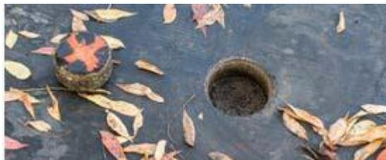
Abbildung 7: Entfernen des Bohrkerns aus dem Bohrloch
